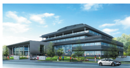
JR豊岡駅前に学舎を建設中。
